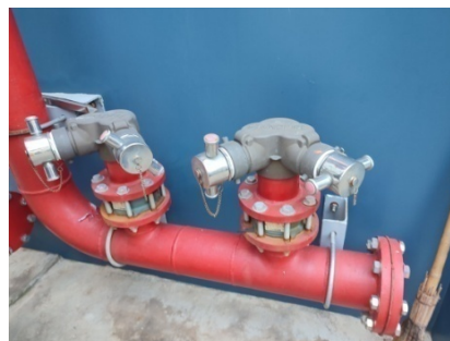
ภาพที่ 4-19 หัวรับน้ำดับเพลิงจากภายนอกอาคาร A และอาคาร B
