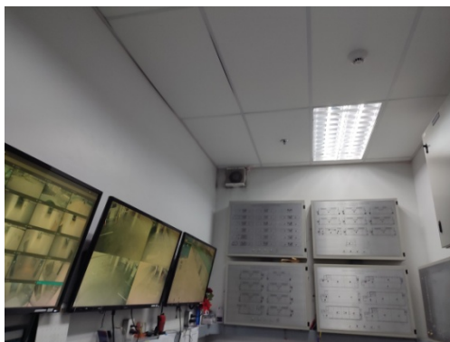
ภาพที่ 4-22 แผงควบคุมการรับส่งสัญญาณอัคคีภัย
