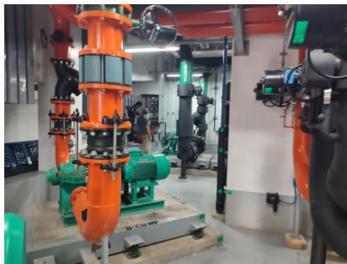
ภาพที่ 4-18 ระบบท่อเย็นของอาคาร และปั๊มสูบน้ำดับเพลิง
